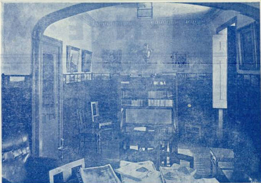
Monte Estoril — Comissão de Iniciativa — Sala da Biblioteca Comision de Iniciativa — Sala de la Biblioteca Comission d'Iniciative — Salle de la bibliotheque
