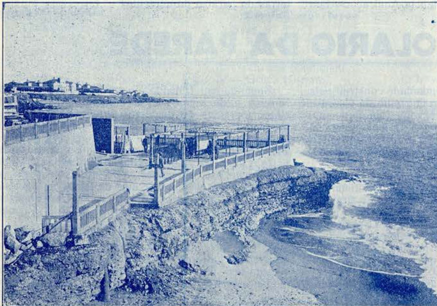
O «Solario» visto do ponte
