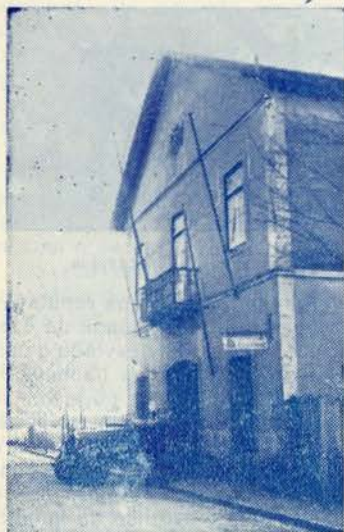
Fachada do Quartel dos Bombeiros Voluntarios de Carcavelos
