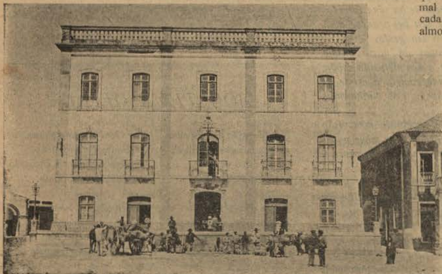
LAGOS - EDIFÍCIO DA CAMARA
