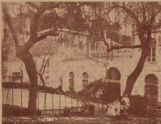
CALDAS DE MONCHIQUE EDIFICIO BALNEAR E CASINO
