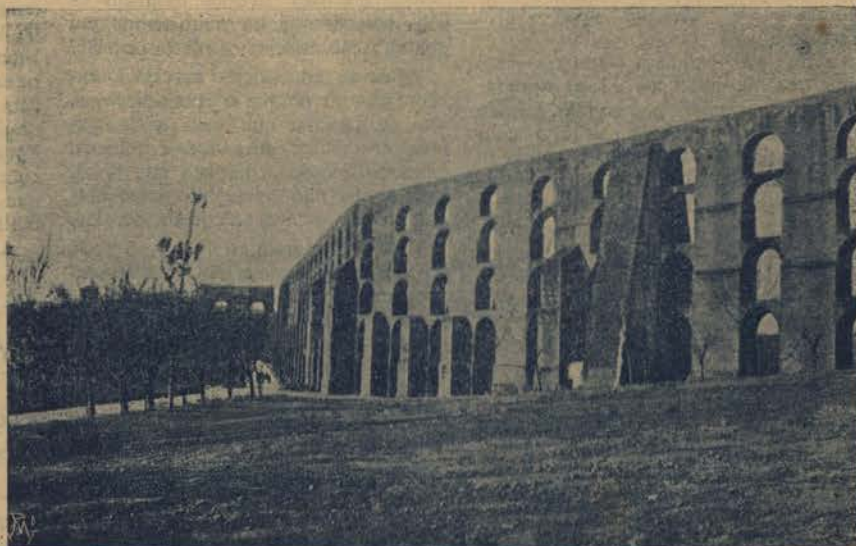
ELVAS - AQUEDULO DA AMOREIRA
