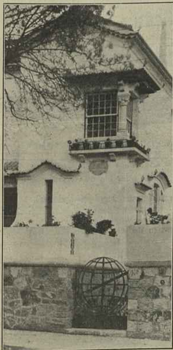
DETALHE DA FACHADA — ENTRADA E JANELA DE ANGULO
