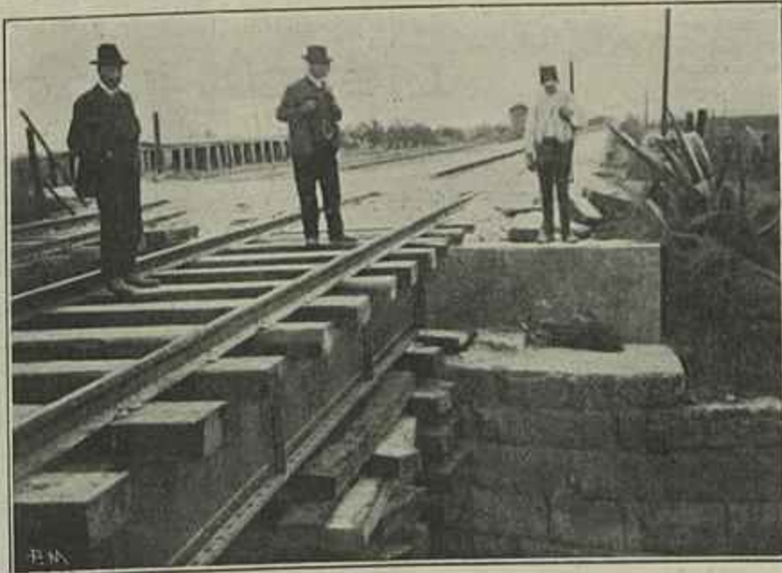
PONTÃO DO CARREGADO DESTRUIDO POR DINAMITE
