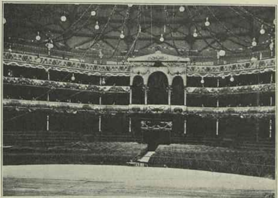
COLISEU DOS RECREIOS A SALA DE ESPETACULO DEPOIS DAS OBRAS QUE LHE FIZERAM
