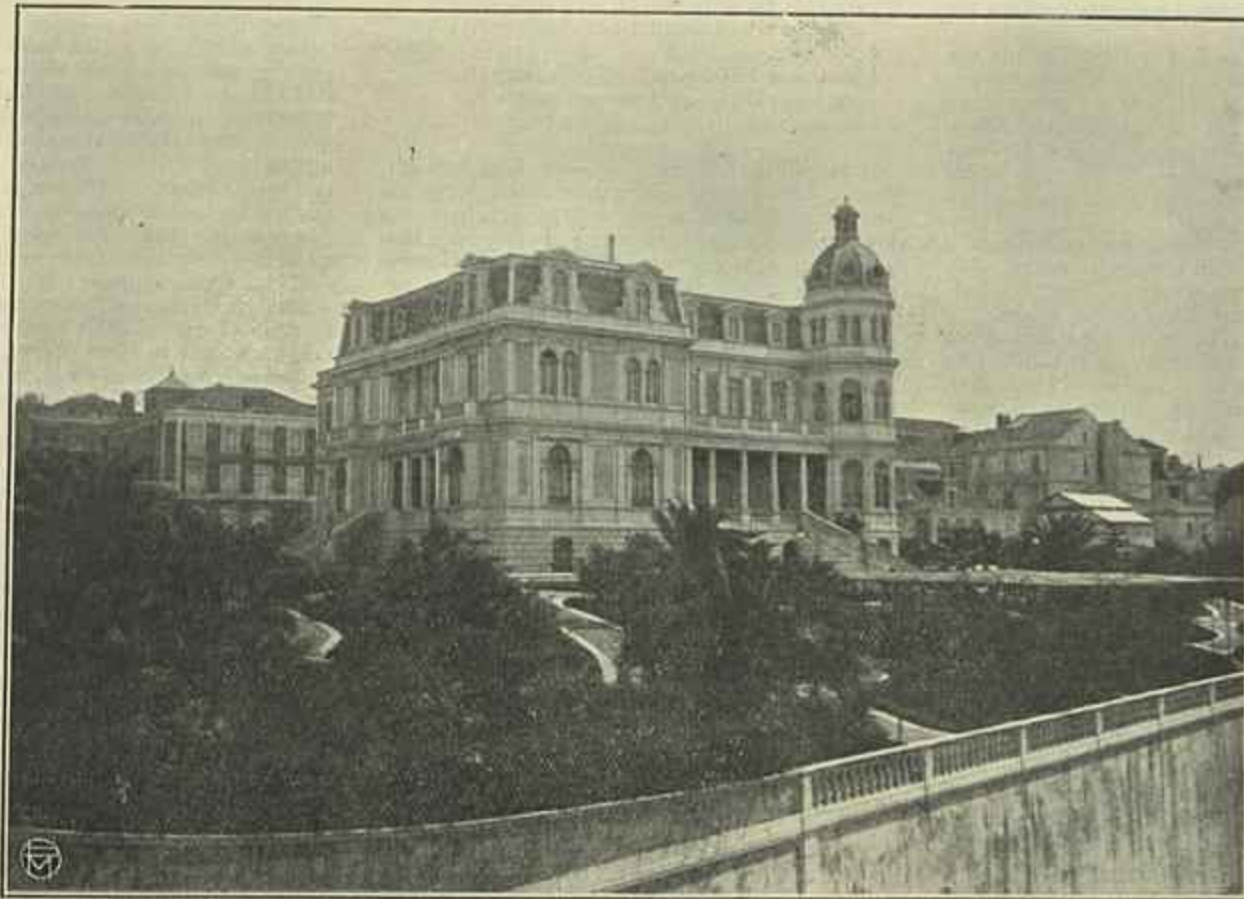
O PALACIO DO SR. CANDIDO SOTTO MAIOR, NA AVENIDA FONTES PEREIRA DE MELLO Arquiteto sr. Ezequiel Bandeira.
