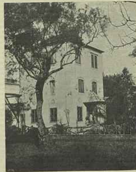
FACHADA DO SUL
