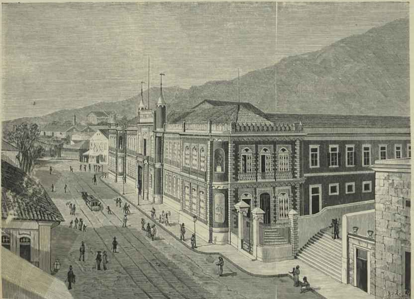
O EDIFÍCIO DA IMPRENSA NACIONAL DO RIO DE JANEIRO, QUE FOI DESTRUÍDO POR INCENDIO, EM 16 DO CORRENTE
