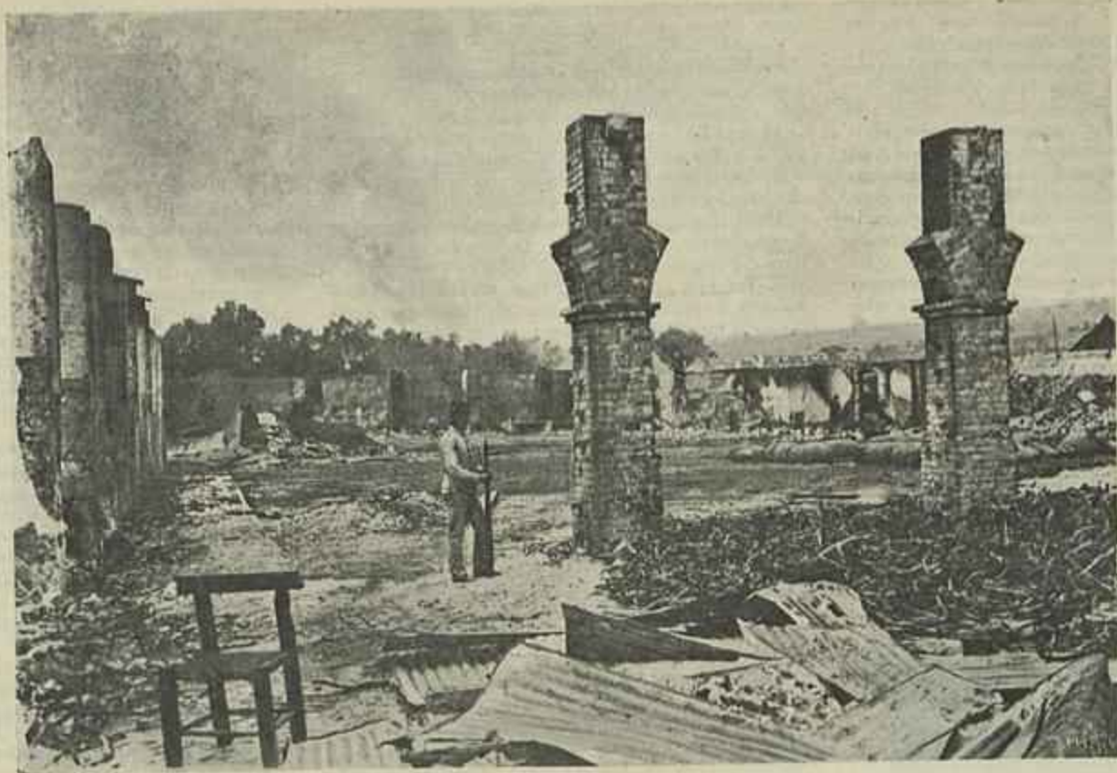
O INCENDIO NO CARAMUJO — RUINAS DAS FABRICAS INCENDIADAS
