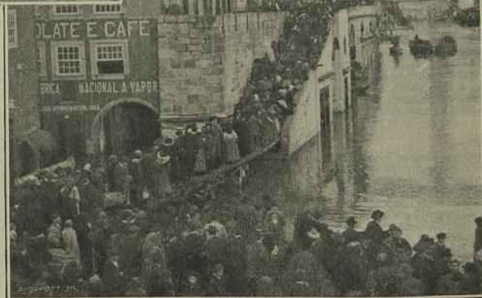
PORTO — EM MASSARELOS REFORÇANDO AS AMARRAÇÕES DOS NAVIOS QUE VÃO À PESCA DO BACALHAU — A INUNDAÇÃO EM MIRAGAIA — INUNDAÇÃO DO CAES DA RIBEIRA, PASSAGEM IMPROVISADA DA RUA DE S. JOÃO PARA CIMA DO MURO.
