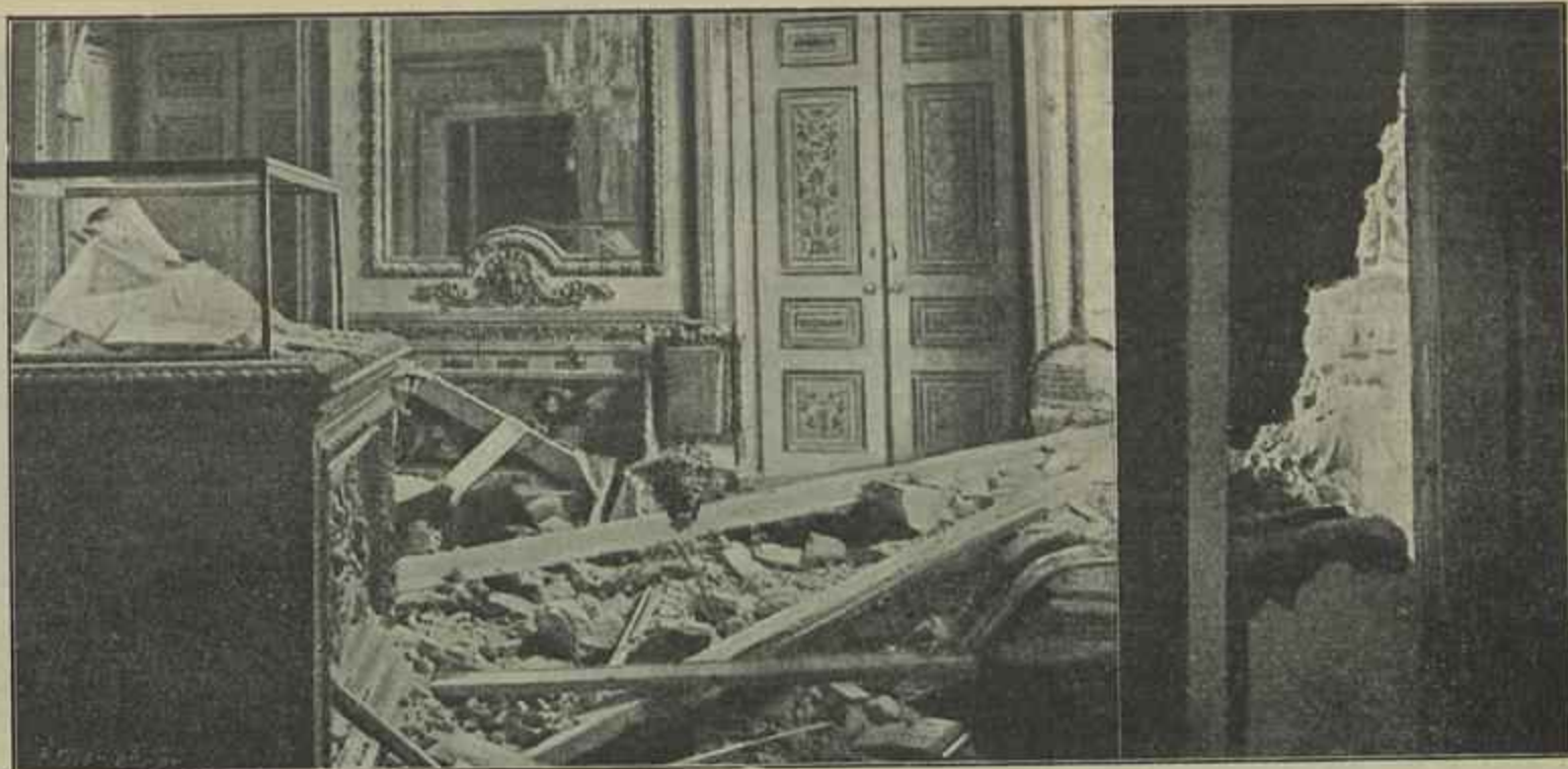
DESTROÇOS PRODUZIDOS PELAS GRANADAS QUE CAHIRAM NO PALACIO DAS NECESSIDADES — SALA INTIMA DO SR. D. MANUEL. — BRECHA ABERTA, POR UMA GRANADA NA PAREDE DO VÃO DE UMA JANELA
