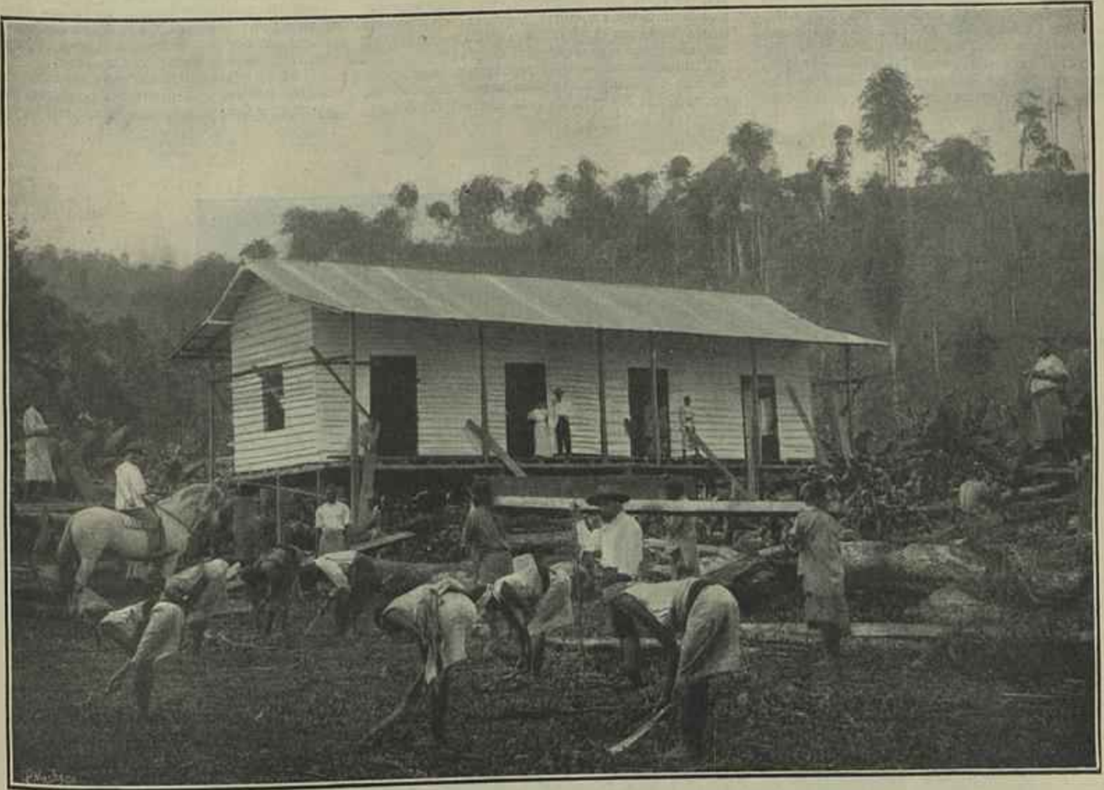
PREMIERS TRAVAUX POUR UNE INSTALLATION
