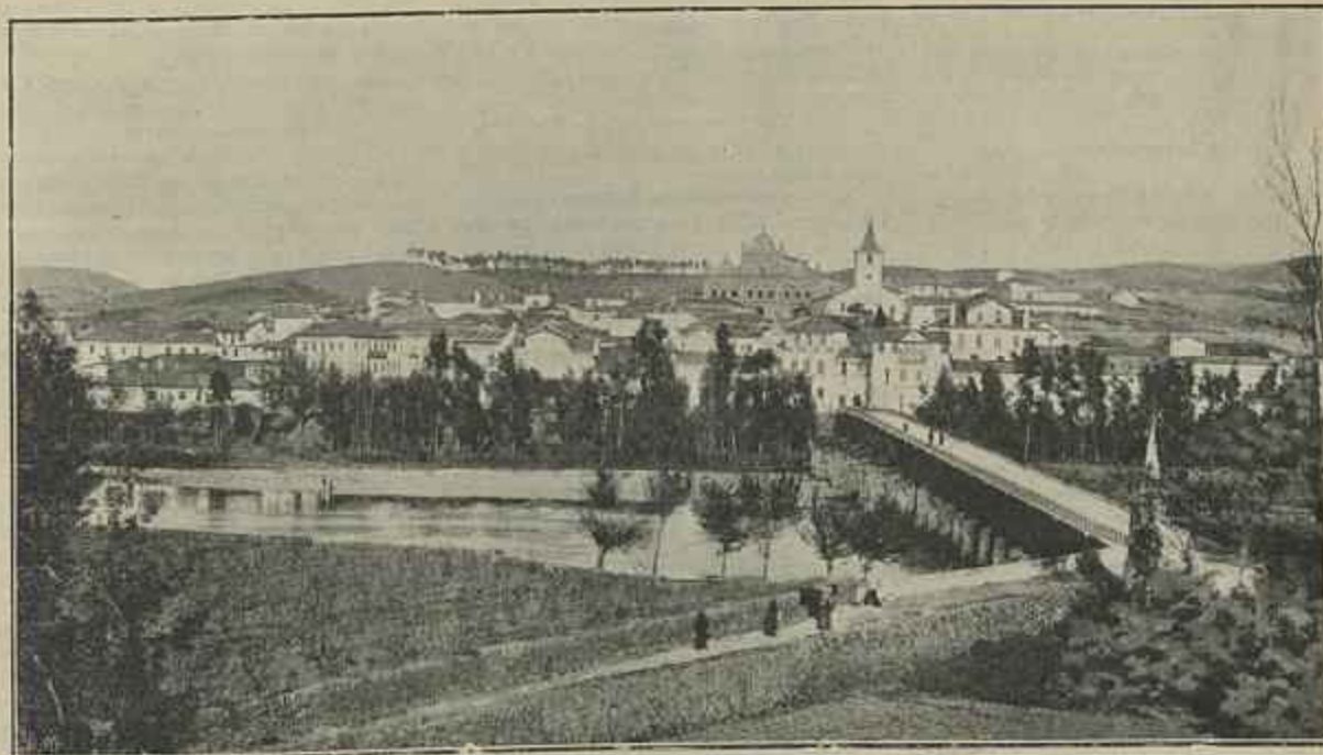
A PONTE DE MIRANDELLA QUE FOI DESTRUIDA EM PARTE PELA CHEIA
