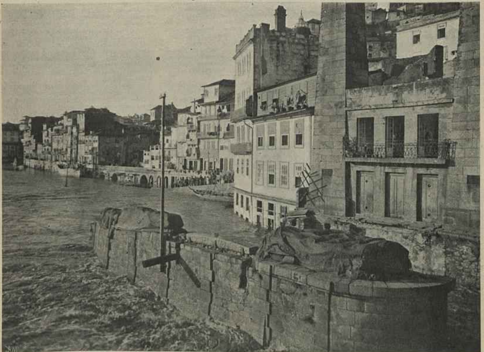
NO PORTO, A INUNDAÇÃO NO SITIO DA ANTIGA PONTE PENSH. (De fotografias)
