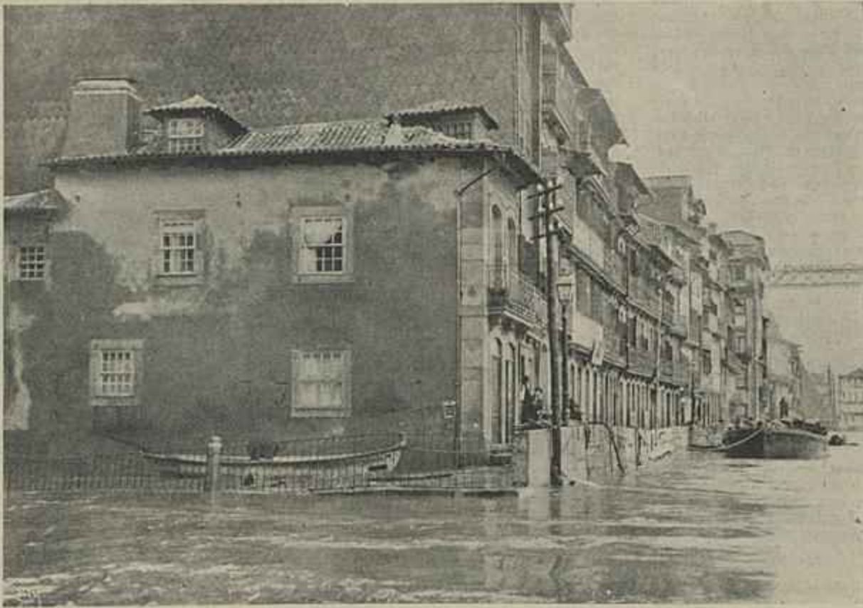
NO PORTO, A INUNDAÇÃO NO MURO BACALHOEIRO
