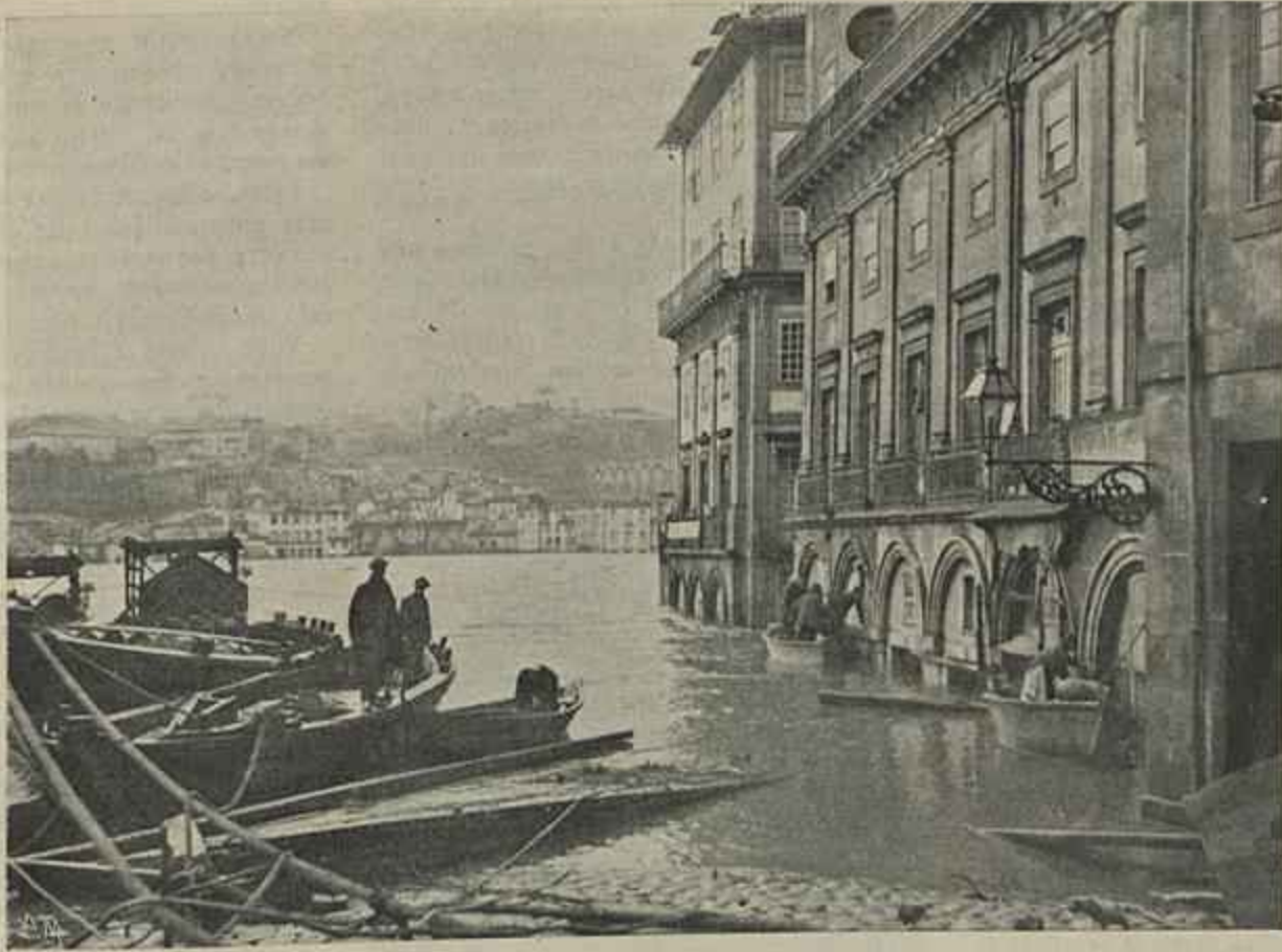
A INUNDAÇÃO NA RUA DE S. JOÃO DA RIBEIRA, NO PORTO
