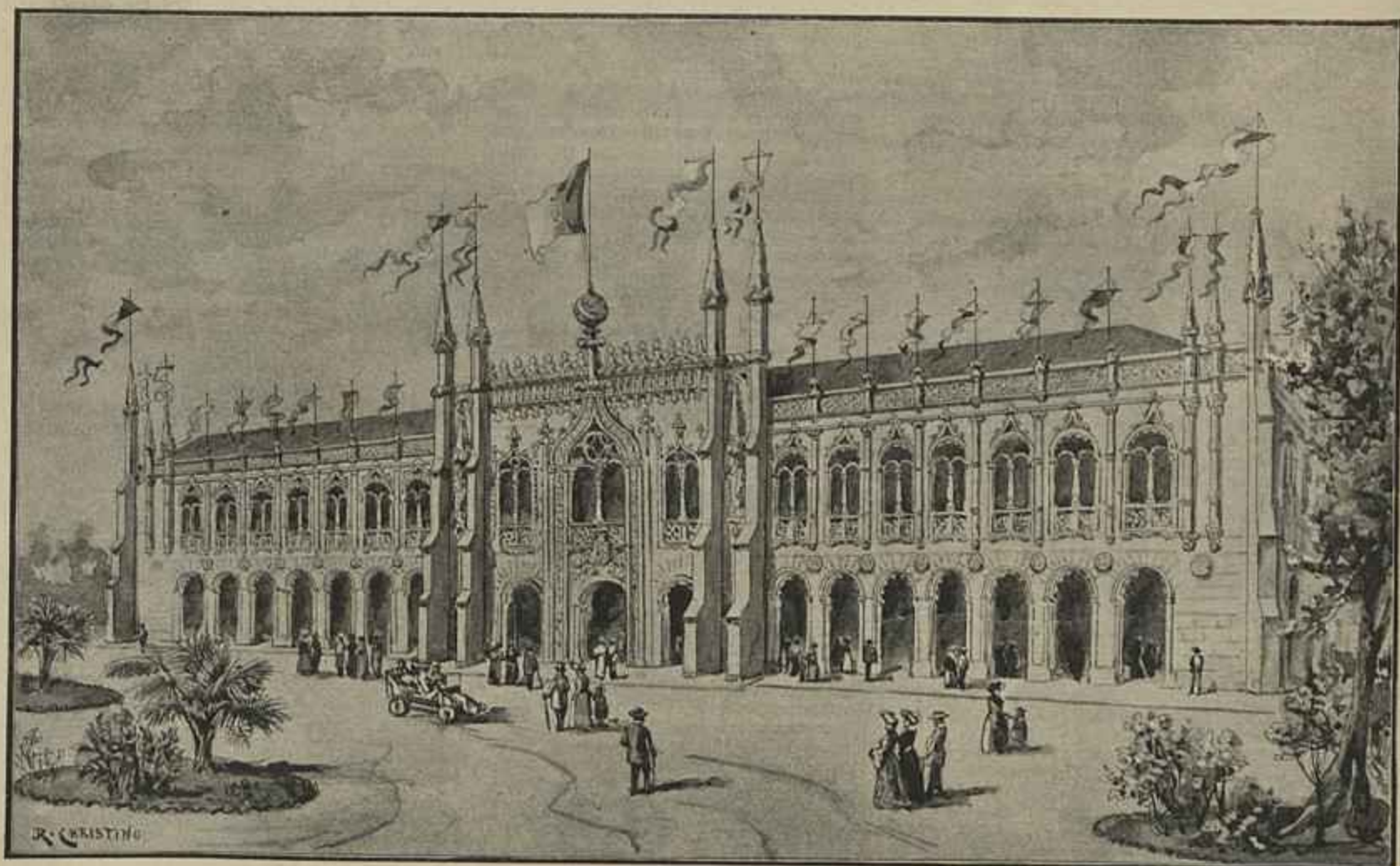
EDIFÍCIO DA SECÇÃO PORTUGUESA NA EXPOSIÇÃO NACIONAL DO RIO DE JANEIRO (Desenho do sr. R. Christino)
