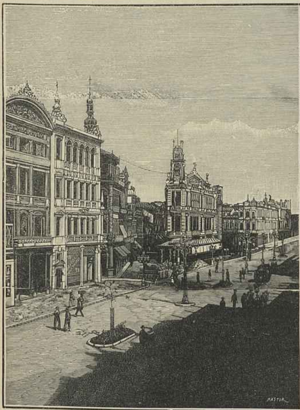
ASPECTOS DA NOVA AVENIDA CENTRAL, EM CONSTRUÇÃO, NO RIO DE JANEIRO
