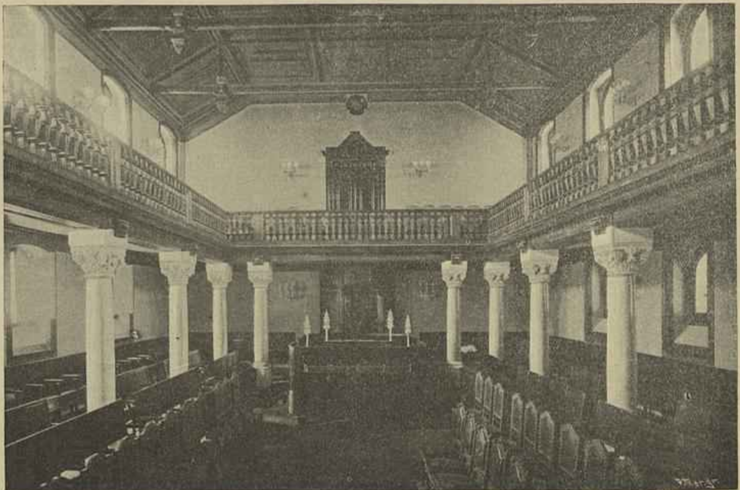
VISTA INTERIOR DA SYNAGOGA — A «TEBA»
