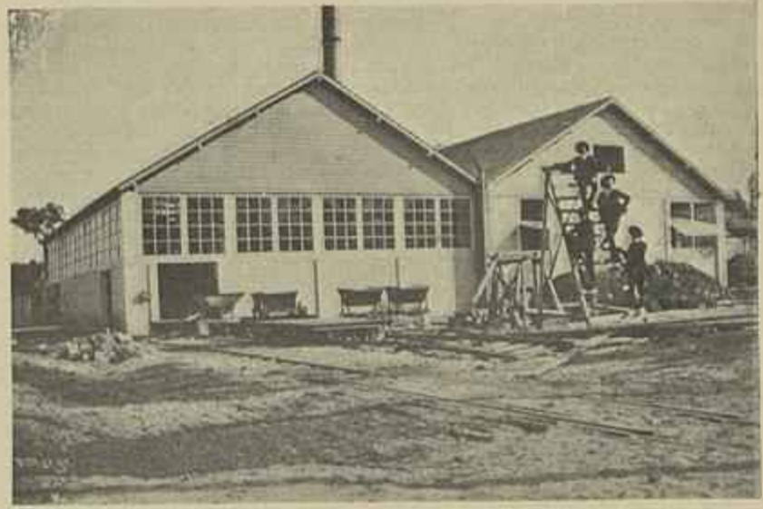
FABRICA DE TIJOLOS SILICO-CALCAREOS VISTA EXTERIOR
