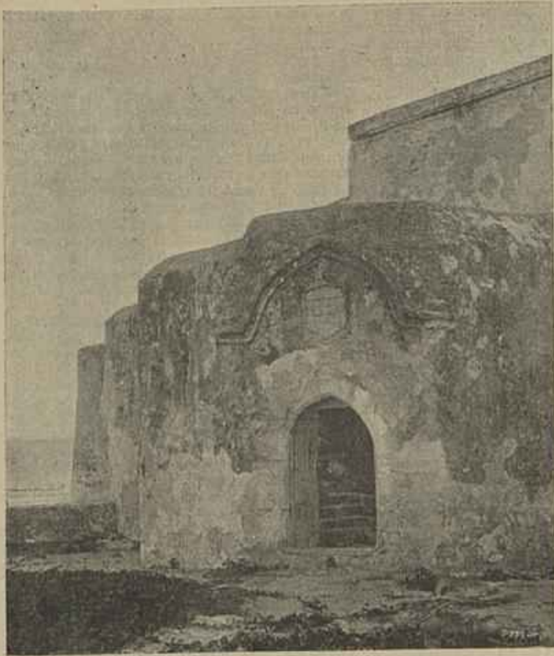
ENTRADA PRINCIPAL DA FORTALEZA DE SOFALA
