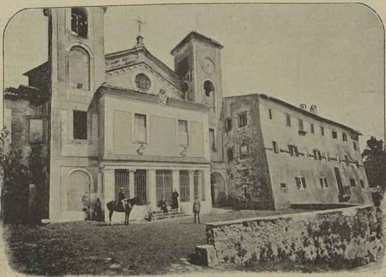
O CONVENTO DE PALAZZOLA
