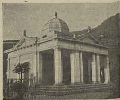
A «MORGUE» NO CEMITERIO DE CLARENS ONDE FICOU DEPOSITADO O CORPO DE KRUGER
