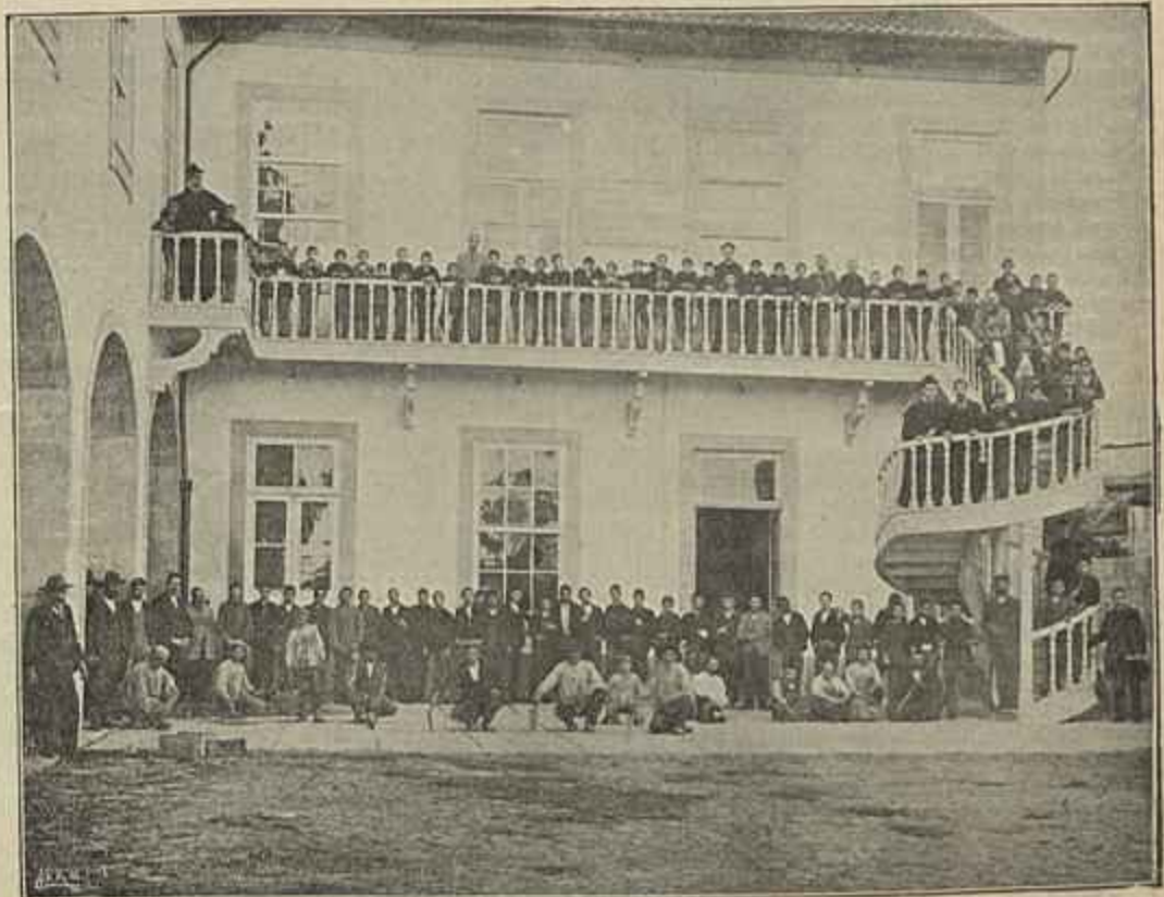
REAL OFFICINA DE S. JOSÉ, NO PORTO — ESCADA EM CIMENTO ARMADO
