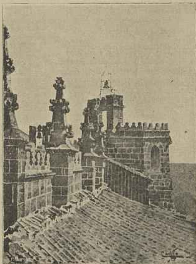
PARTE SUPERIOR DA TORRE, NA FACHADA NORTE
