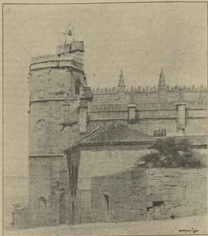
FACHADA DO SUL
