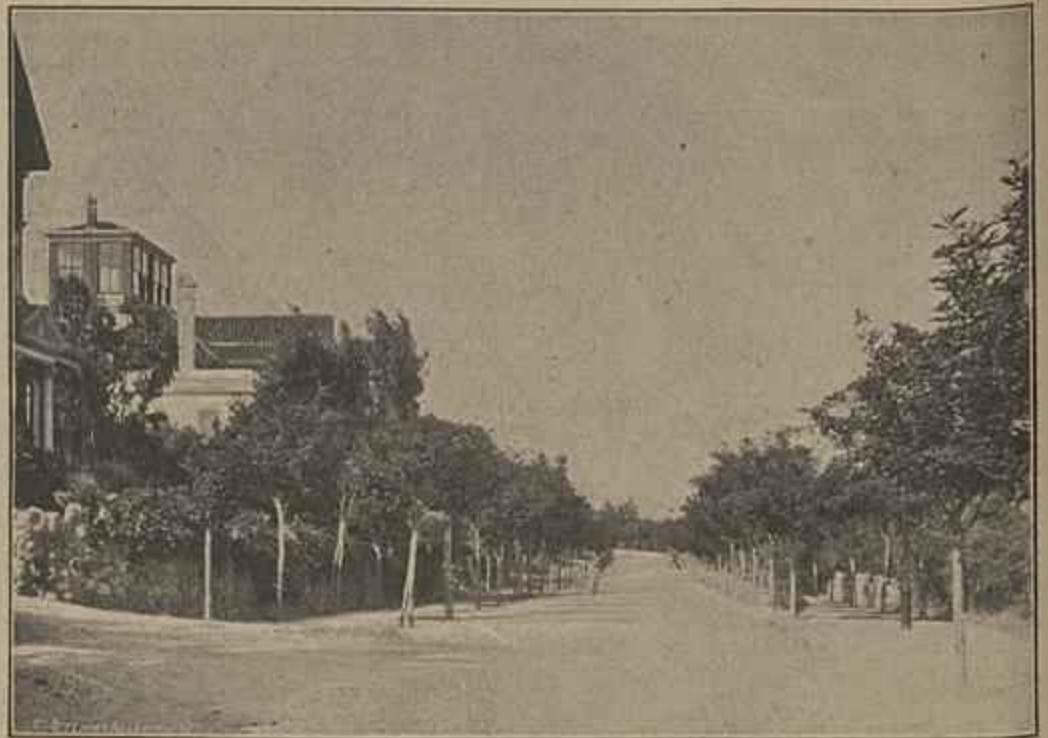
MONT'ESTORIL — AVENIDA SABOYA
