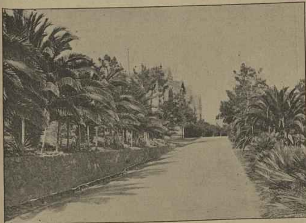
MONTESTORIL. — RUA DE ARCAÇOU
