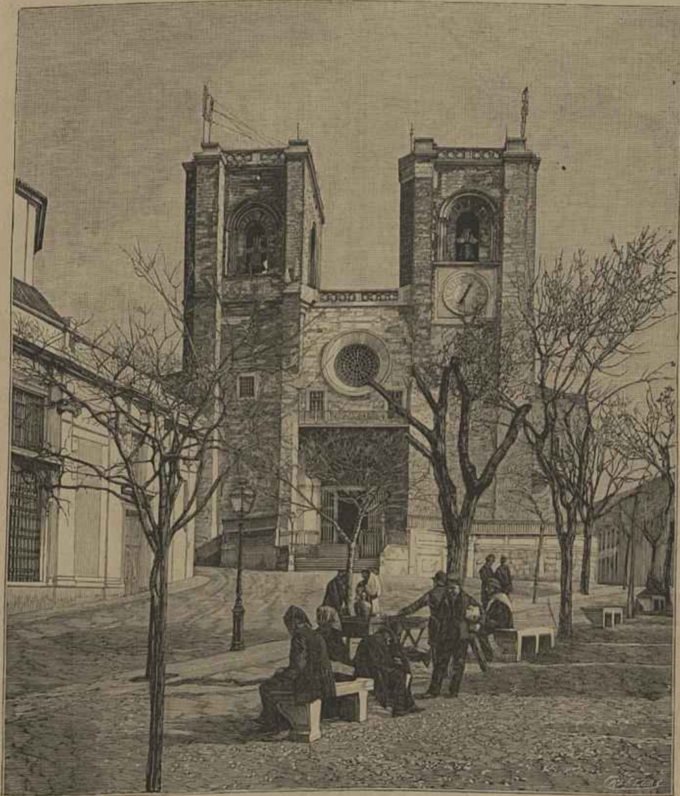
ESTADO ACTUAL DO EDIFICIO
