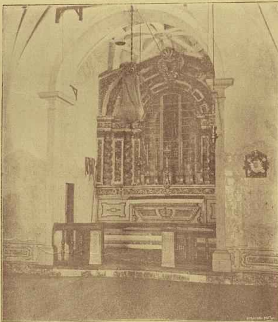
SINES — INTERIOR DA EGREJA DE NOSSA SENHORA DE SALLAS
