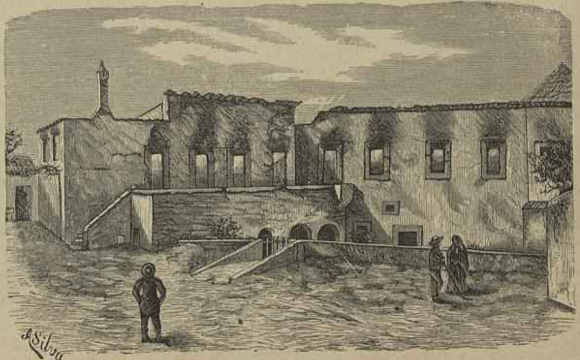
RUINAS DA CASA DEPOIS DO INCENDIO, VISTA DO LADO DO QUINTAL
