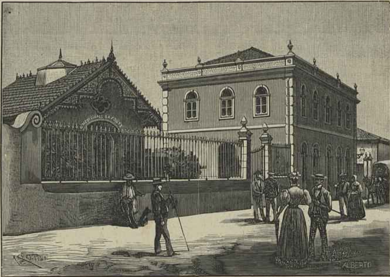
ESTABELECIMENTO DAS AGUAS DA FONTE NOVA EM TORRES VEDRAS—INAUGURADO EM 23 DE MAIO DE 1895
