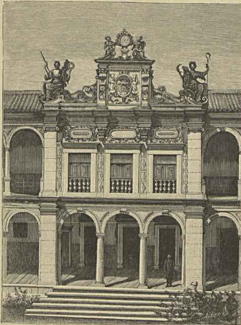
UNIVERSIDADE DE EVORA — FACHADA DA SALA DOS AÇOS
