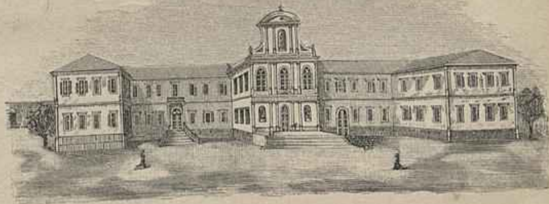
EDIFICIO DA SANTA CASA DA MISERICORDIA
