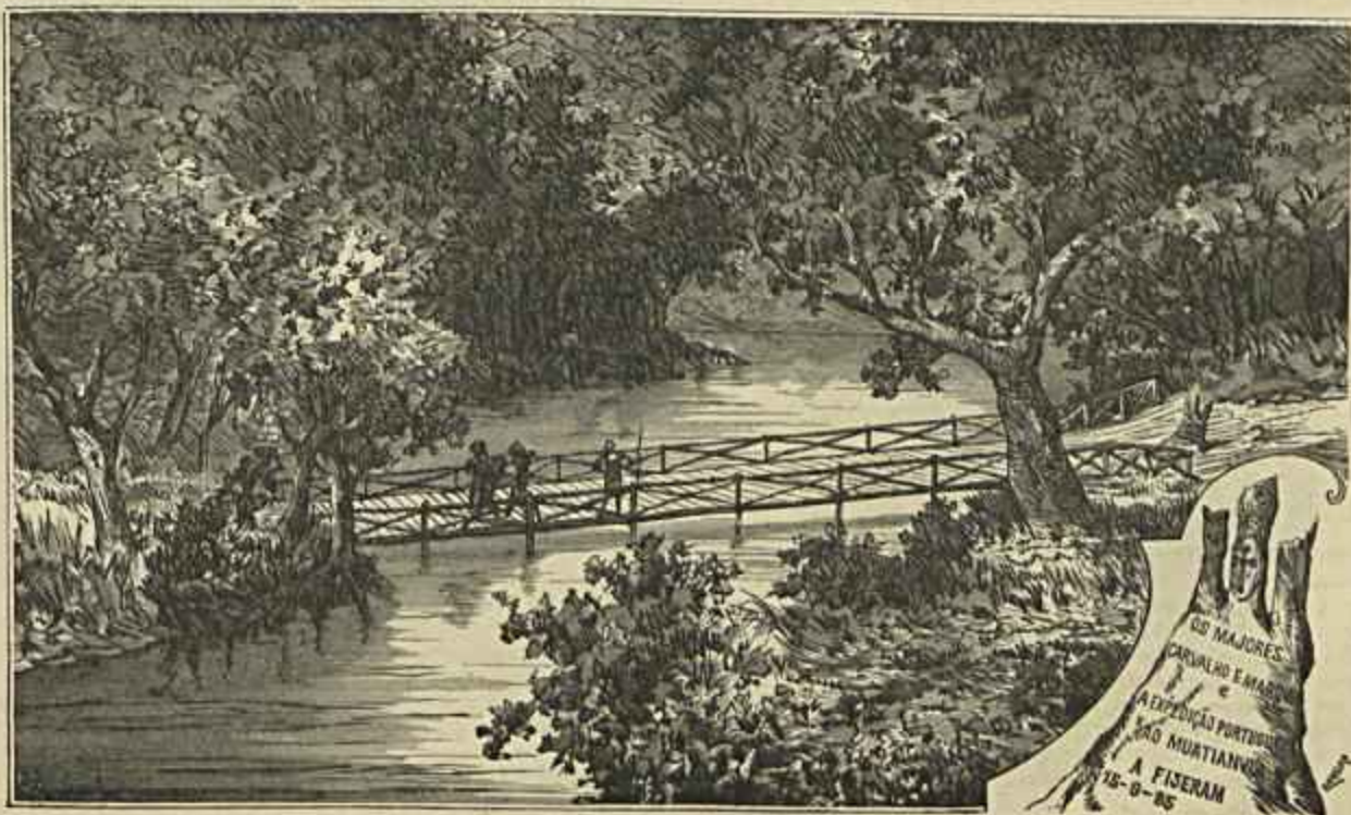
PONTE DO CUANGO, CONSTRUIDA PELA EXPEDIÇÃO
