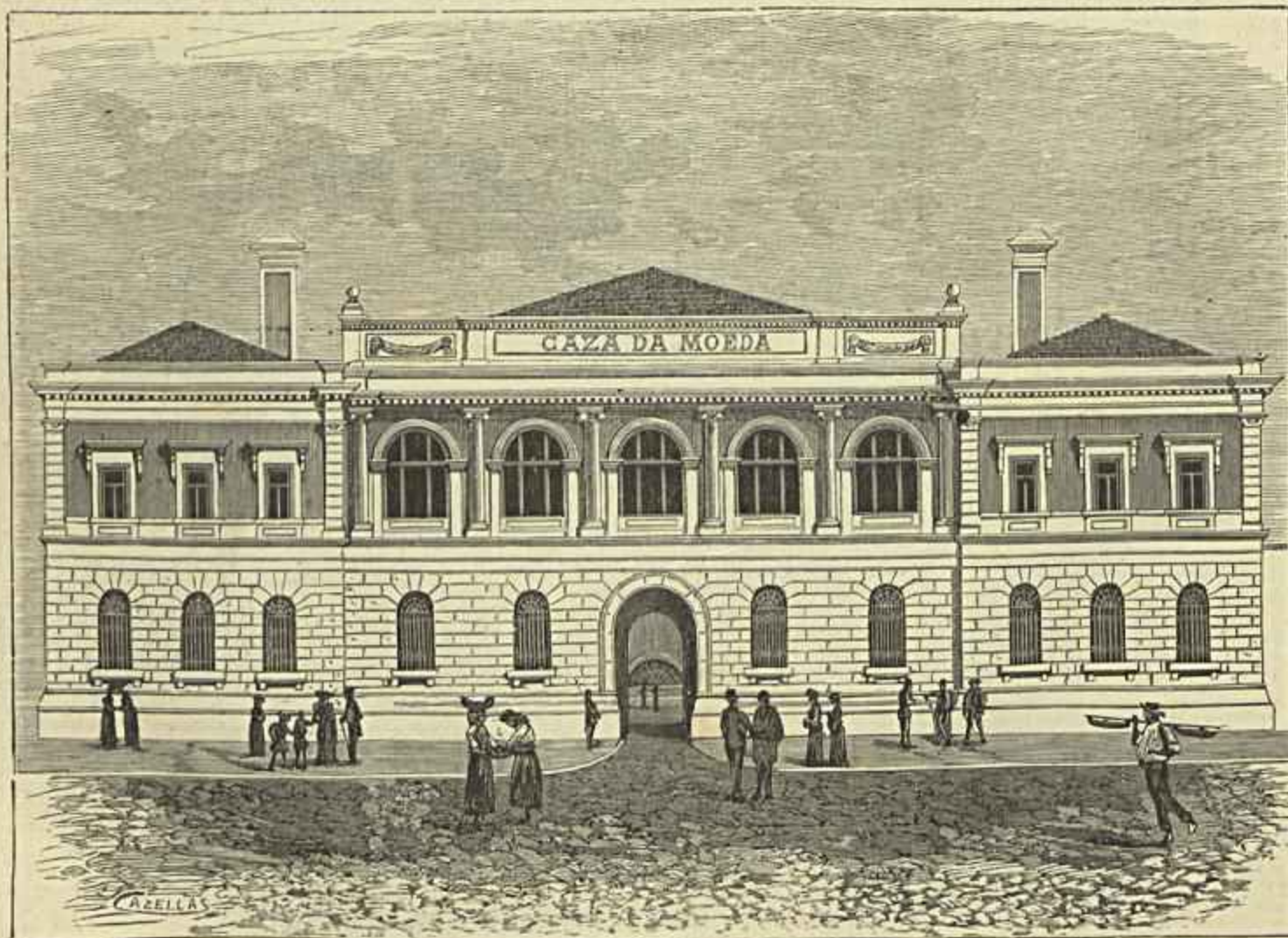
A CASA DA MOEDA DE LISBOA — A NOVA FRENTE PRINCIPAL
