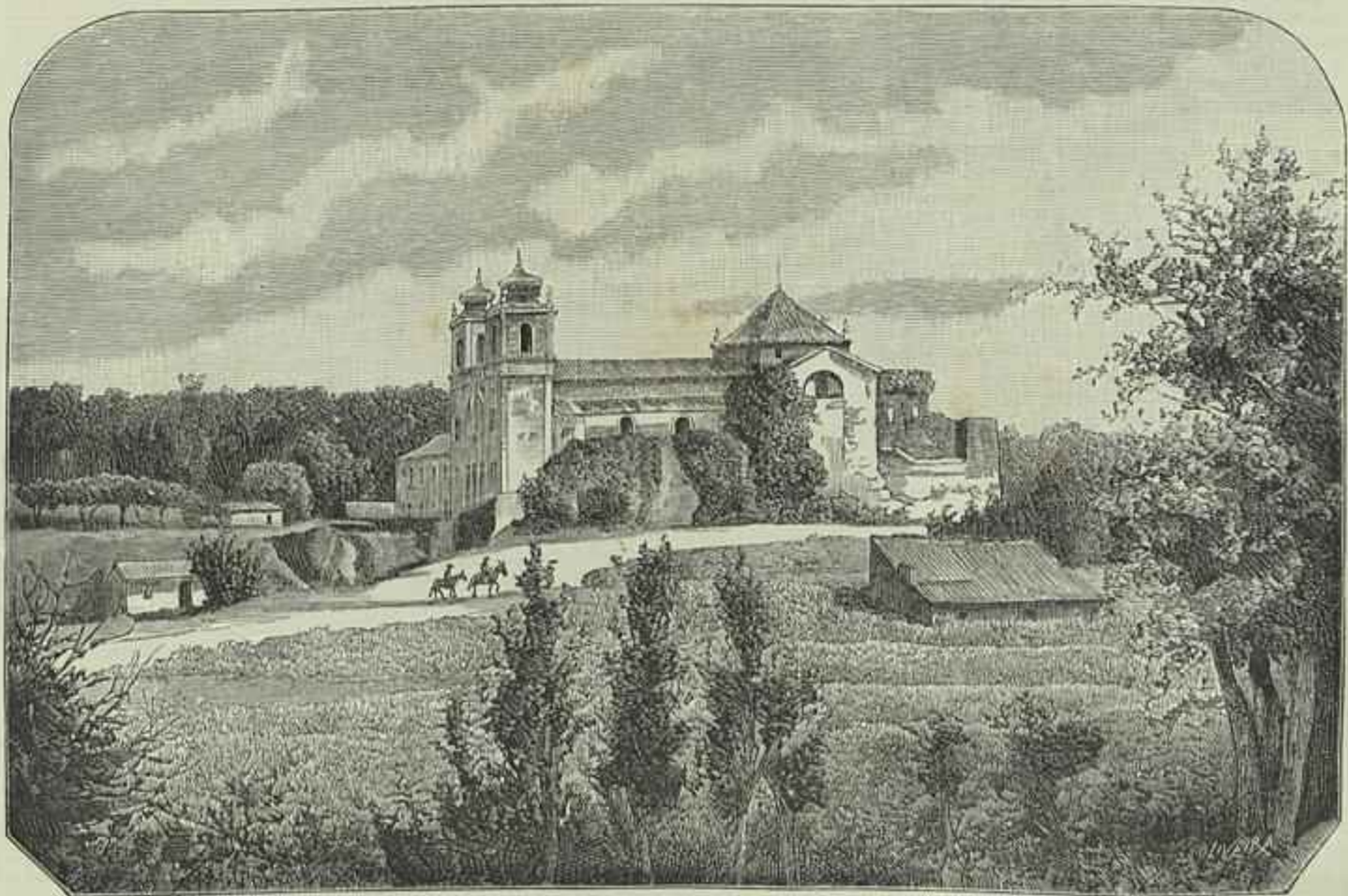
CEIÇA — RUINAS DO MOSTEIRO
