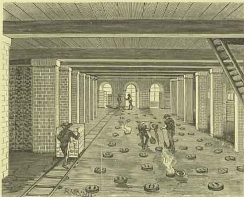
PAVIMENTO SUPERIOR DO FORNO E ENXUGADOUROS
