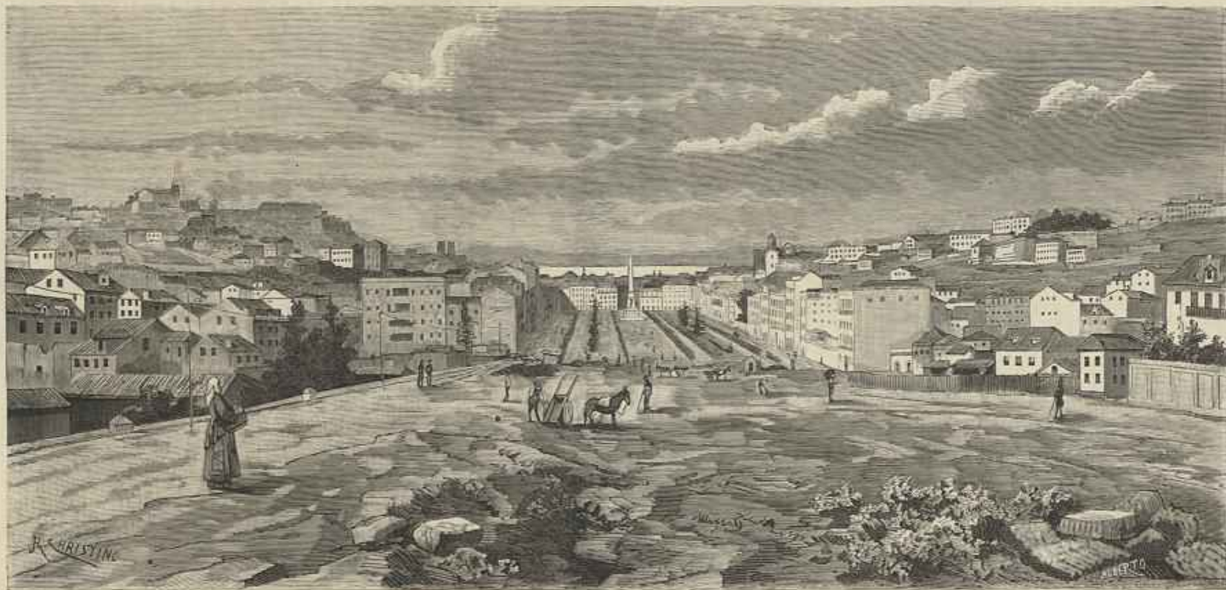
AVENIDA DA LIBERDADE — ESTADO ACTUAL DAS OBRAS (Desenho do natural por J. Christine)
