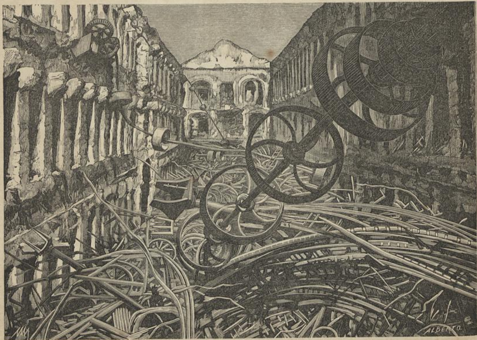
RUINAS DA REAL FABRICA DE FIAÇÃO, EM THOMAR, DEPOIS DO INCENDIO DE 29 DE AGOSTO DE 1883. — Vid. artigo a pag. 203 do presente vol. (Segundo uma photographia de A. S. Magalhães)
