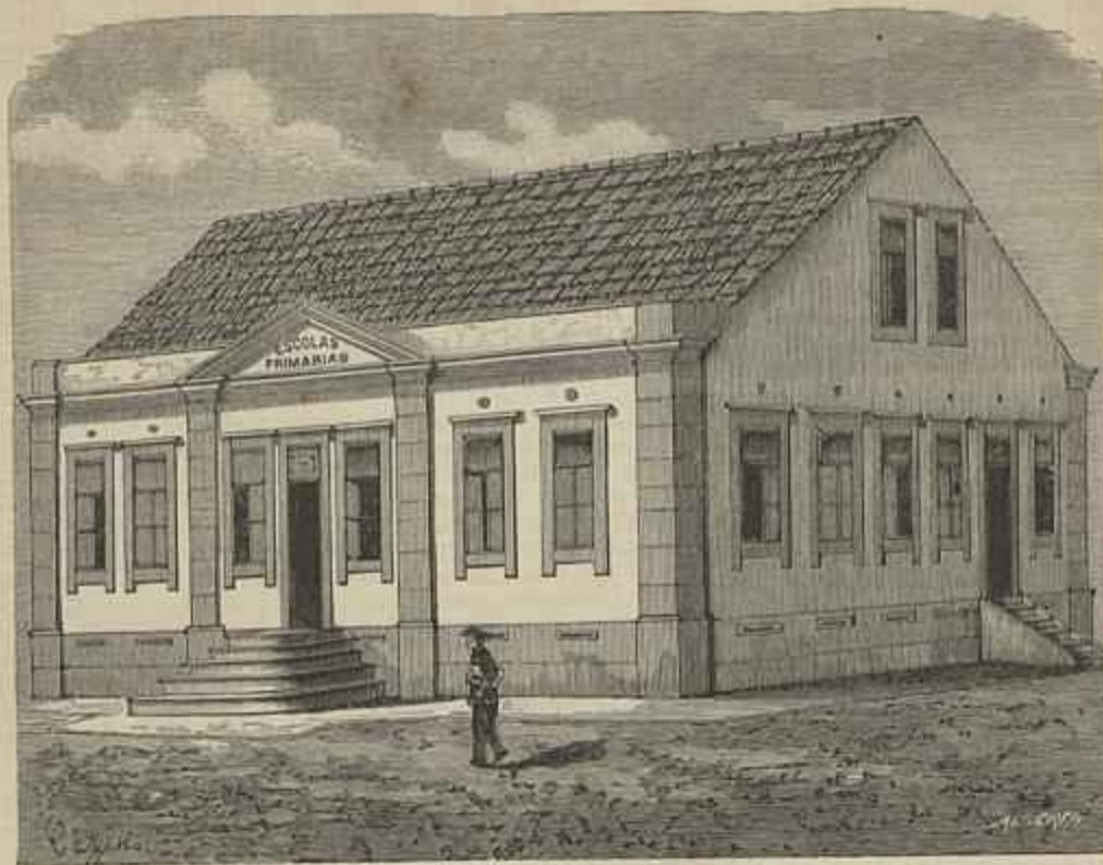
ESCOLA DE INSTRUÇÃO PRIMARIA, EM AVINTES
