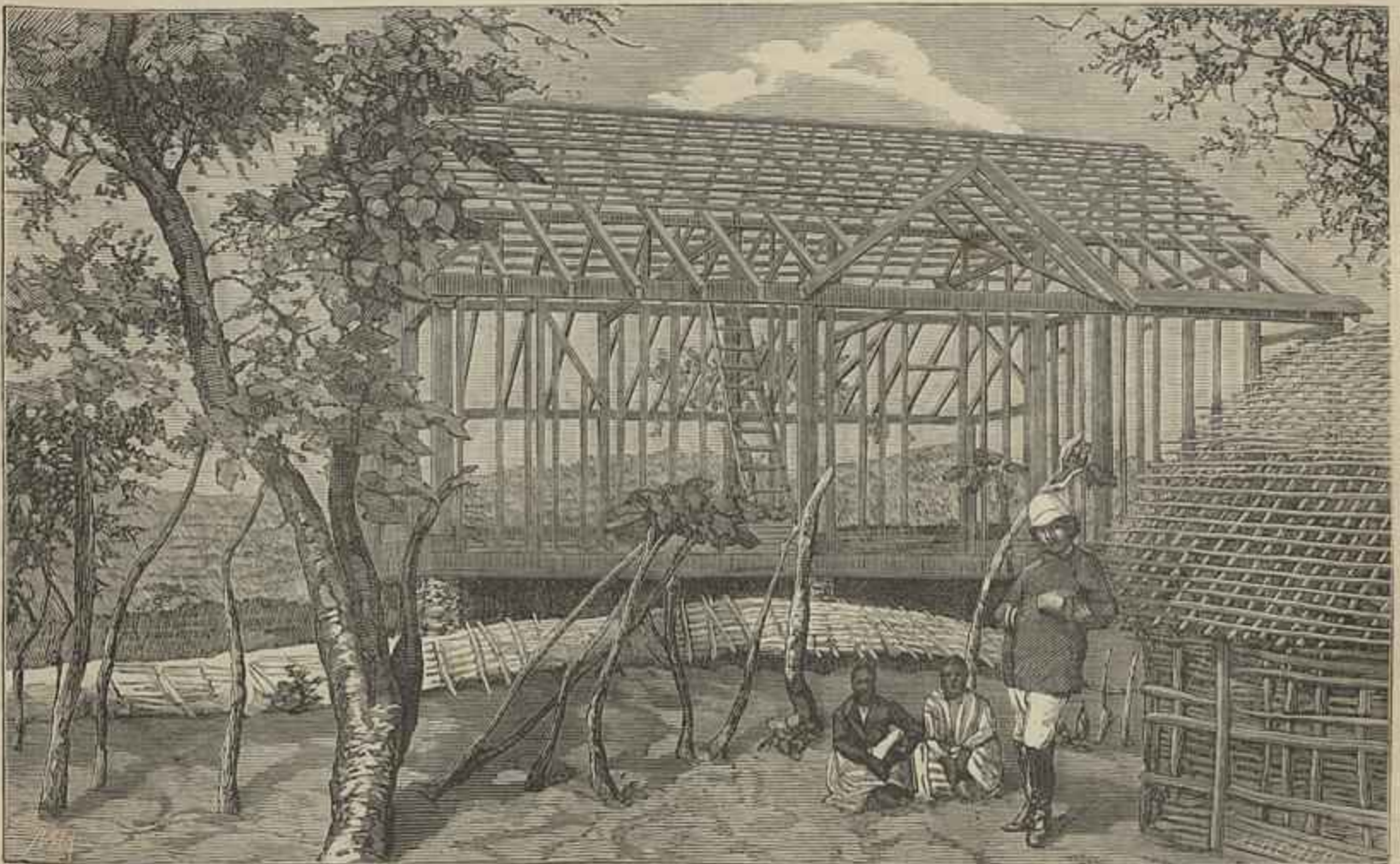
CASA DA MISSÃO PORTUGUEZA NO CONGO, EM CONSTRUÇÃO (Segundo uma photographia). Vid. artigo Major João Carlos Ribeiro, etc.
