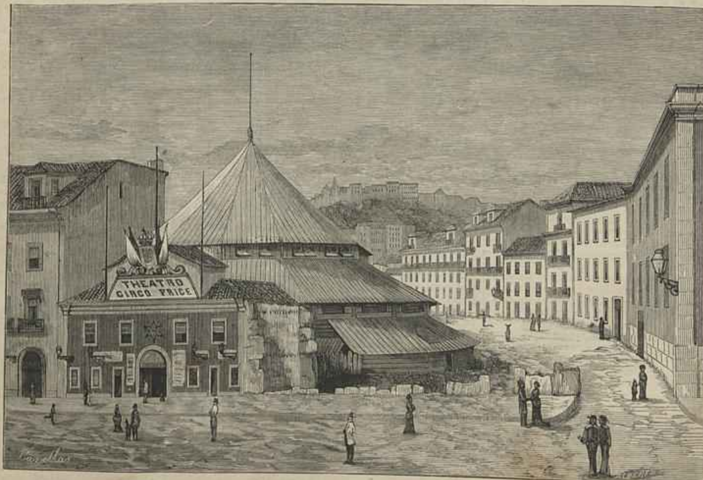
LISBOA — ANTIGO CIRCO PRICE, DEMOLIDO PARA A ABERTURA DA AVENIDA DA LIBERDADE
