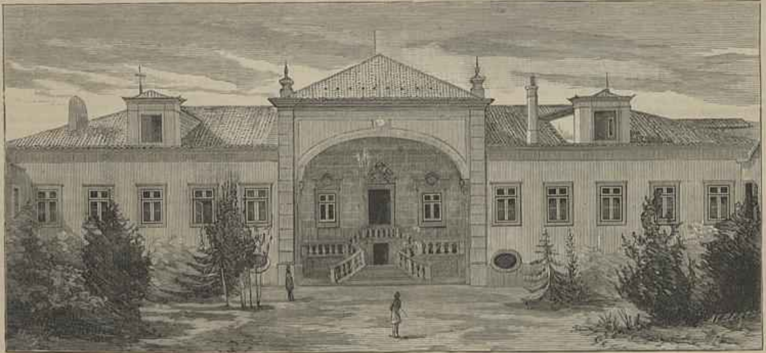
CARCAVELLOS — ESTAÇÃO DO CABO TELEGRAPHICO SUBMARINO, NO ANTIGO PALACIO DO MORGADO DA ALAGÔA (Segundo photographia de Hochlunt)
