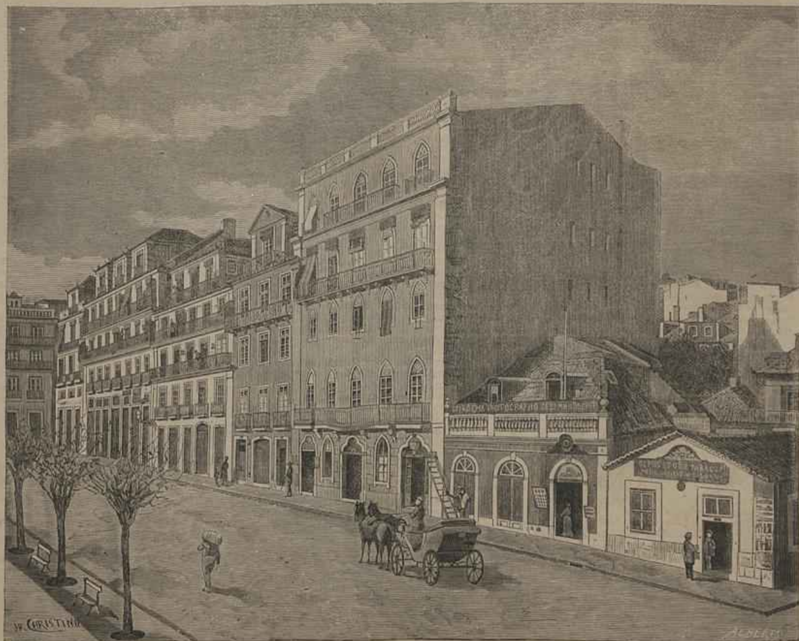
MELHORAMENTOS DE LISBOA. — AVENIDA DA LIBERDADE, PRAÇA DA ALEGRIA DE BAIXO, PREDIOS DEMOLIDOS. (Segundo uma photographia de Rocha.)
