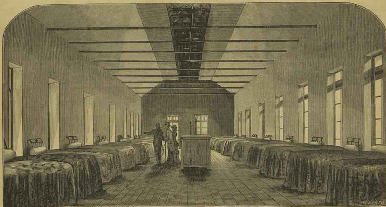
INTERIOR DA TENDA-BARRACA, ANNEXA AO HOSPITAL ESTEPHANIA
