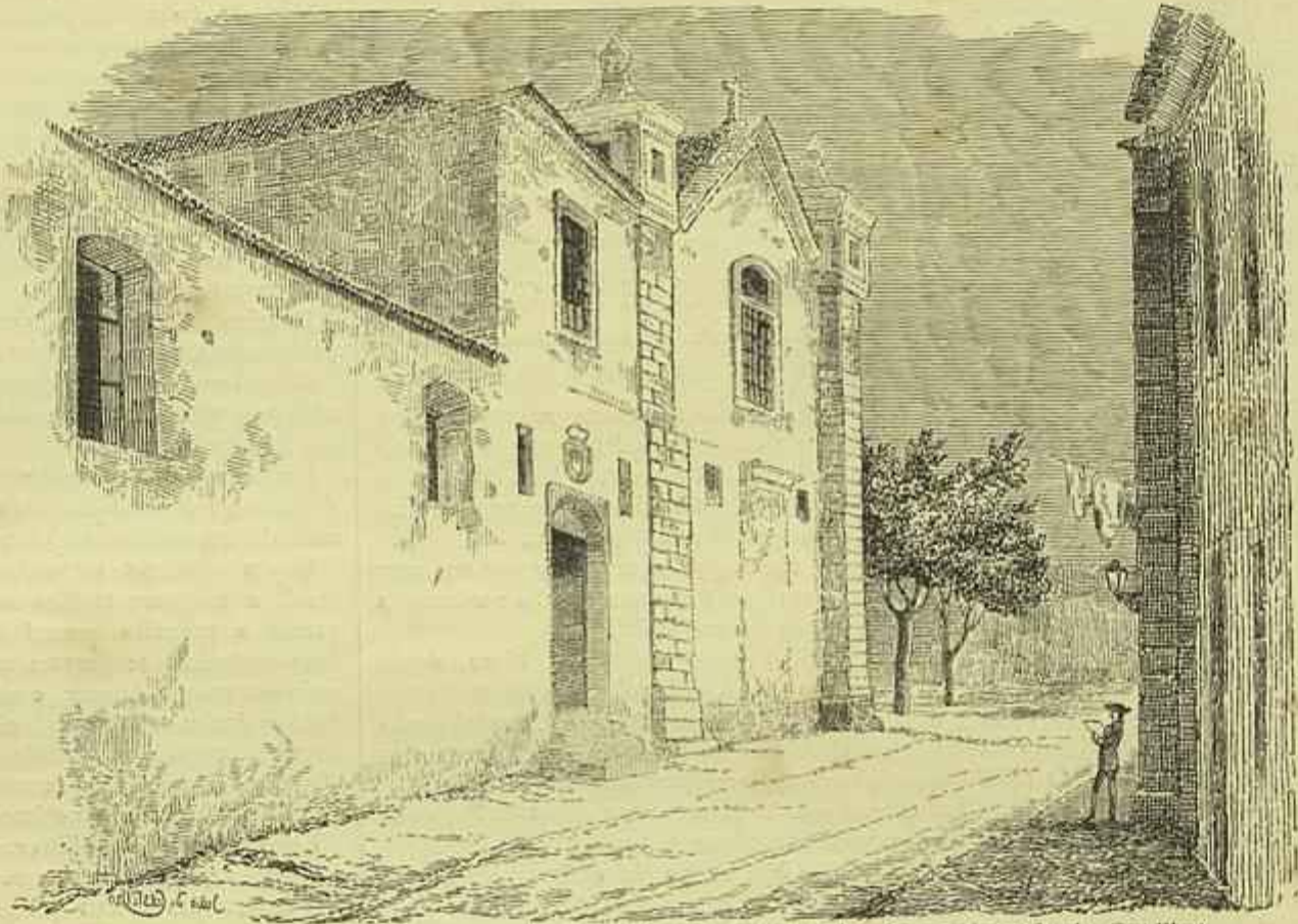
VISTA EXTERIOR DO CONVENTO DE SANT'ANNA — (Desenho autographo do sr. visconde de Castilho)
