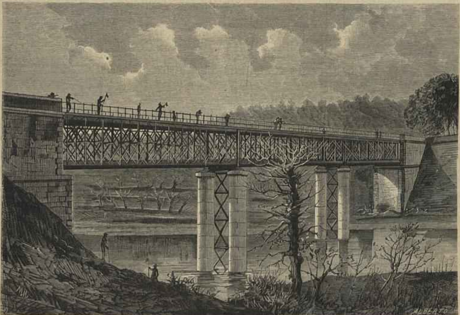
PONTE SOBRE O CÁVADO, JUNTO DE BARCELLOS — (Segundo uma photographia)
