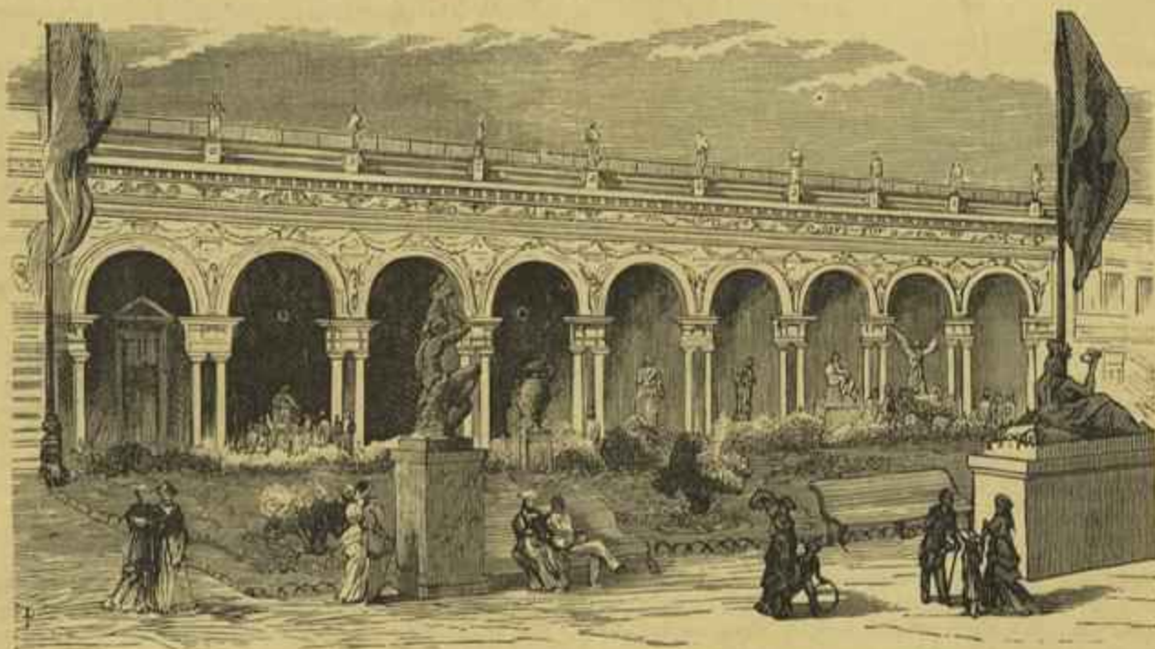
FACHADA DA EXPOSIÇÃO DA AUSTRIA-HUNGRIA NA RUA DAS NAÇÕES (Segundo uma photographia)
