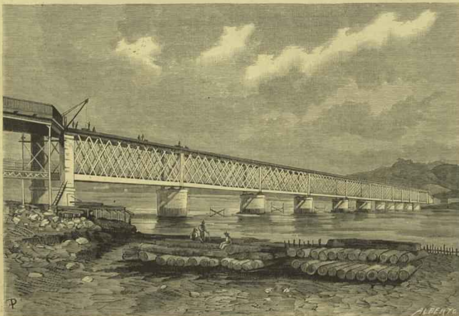
CAMINHOS DE FERRO PORTUGUEZES PONTE METALLICA SOBRE O RIO LIMA, INAUGURADA NO DIA 30 DE JUNHO DE 1878 (Segundo uma photographia)
