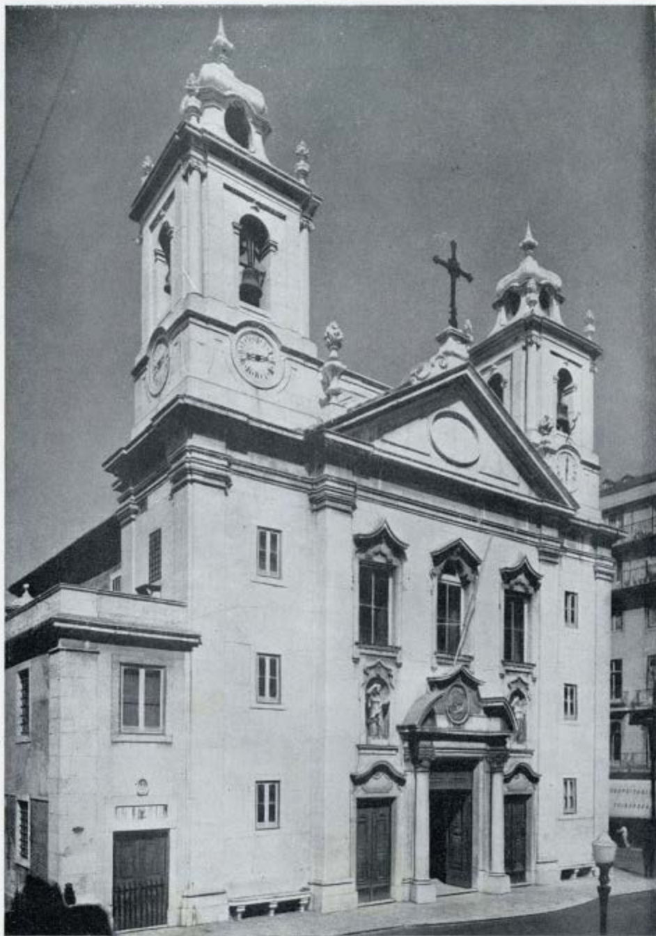
A fachada, já sem a grade do adro, tal como hoje se apresenta
